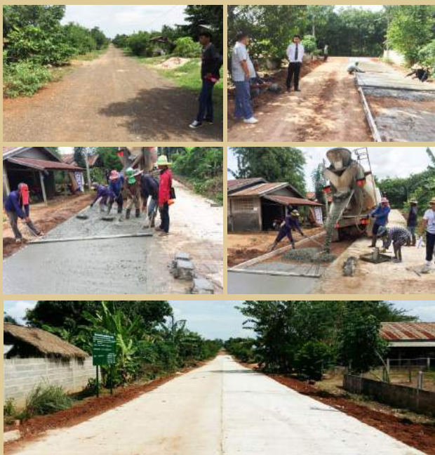
โครงการก่อสร้างถนนคอนกรีตเหล็ก บ้านสันตินิมิตรหมู่ที่ 11
