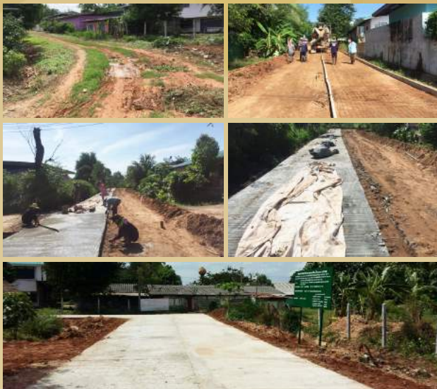
โครงการก่อสร้างถนนคอนกรีตเหล็ก สายตัดโรงเรียนสันติสุข บ้านสันติพัฒนา หมู่ที่ 13
