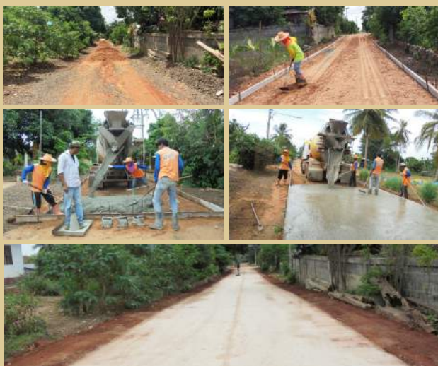
โครงการก่อสร้างถนนคอนกรีตเหล็ก บ้านใหม่ หมู่ที่ 8
