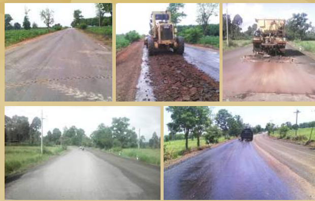
โครงการซ่อมสร้างถนนลาดยางชนิดแอสฟัลต์ทางหลวงท้องถิ่น ภายในตำบลสระตะเคียน
