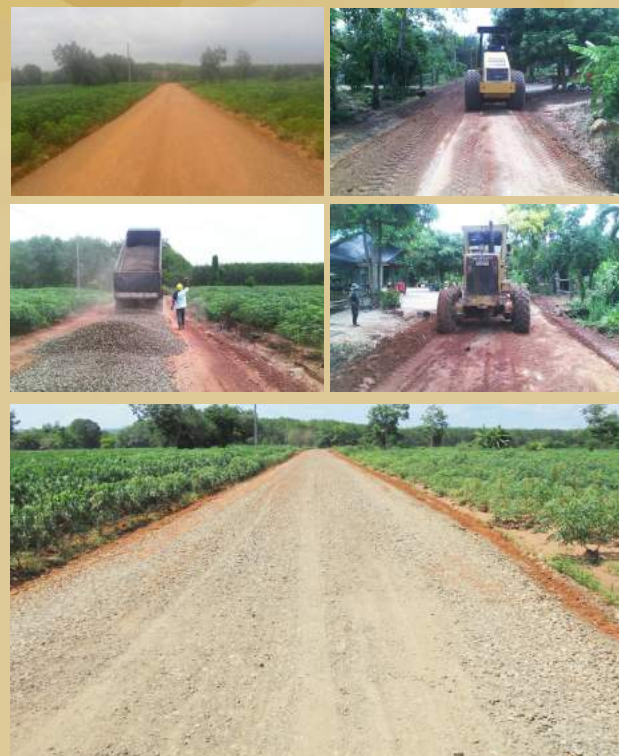
โครงการก่อสร้างถนนหินคลุก สายบุญบ้านโคก-หน้าอ่างเก็บน้ำห้วยเตย
