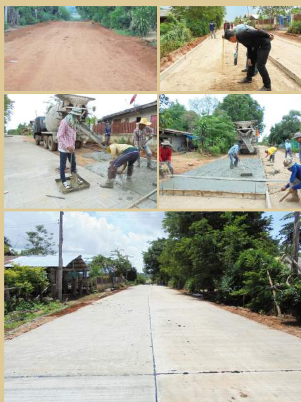
โครงการก่อสร้างถนนคอนกรีตเหล็ก บ้านหนองใหญ่ หมู่ที่ 12
