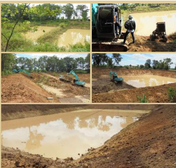
โครงการขุดลอกสระน้ำบ้านใหม่ หมู่ที่ 8
