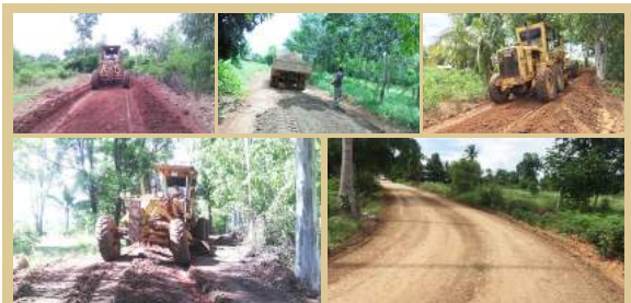
โครงการก่อสร้างถนนหินคลุกสายทางภายในหมู่บ้าน บ้านคลองศรีสุข ม. 9
