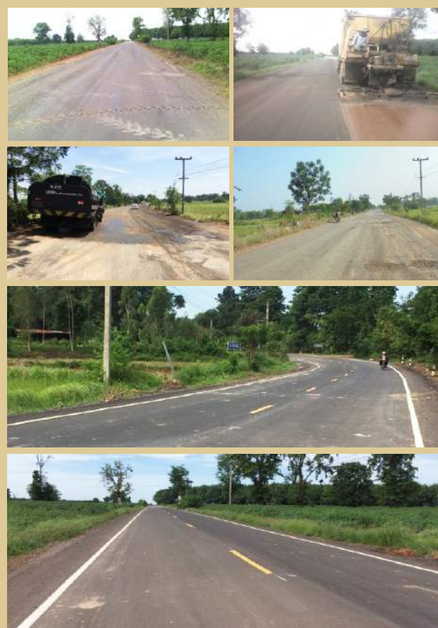
โครงการซ่อมสร้างถนนลาดยางชนิดแอสฟัลท์ทางหลวงท้องถิ่น ภายในตำบลสระตะเคียน
