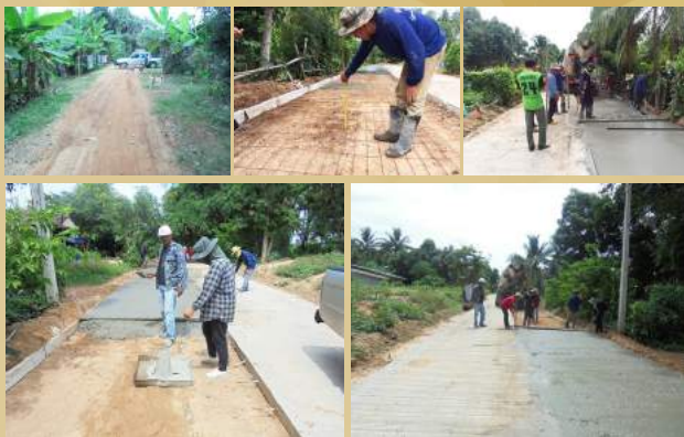
โครงการก่อสร้างถนนคอนกรีตเหล็ก บ้านบู่ หมู่ที่ 7
