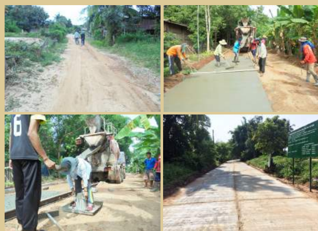
โครงการก่อสร้างถนนคอนกรีตเหล็ก บ้านบู่ หมู่ที่ 7
